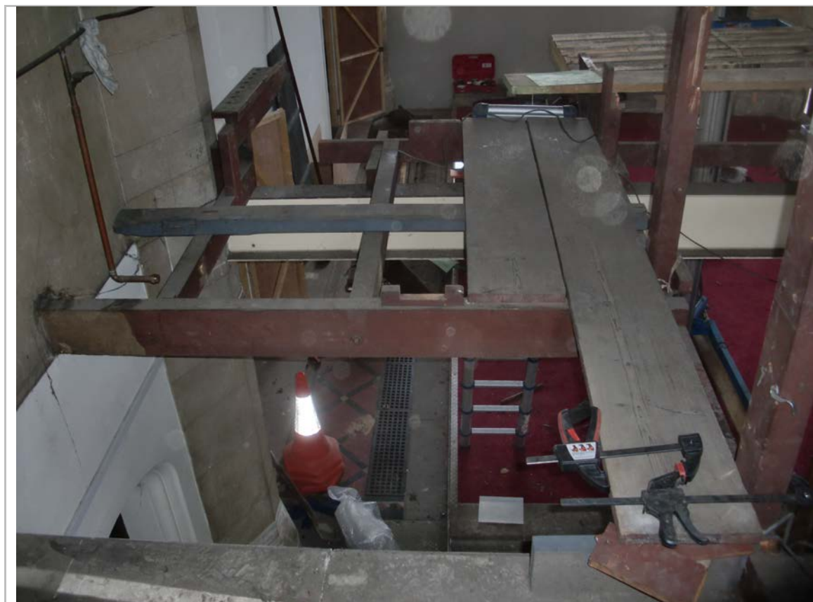
Démontage des passerelles et de la structure porteuse 2
