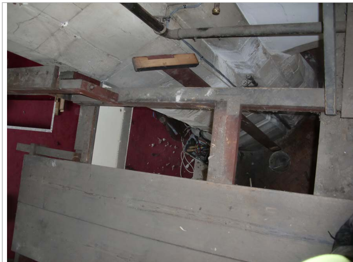
Démontage des passerelles et de la structure porteuse
