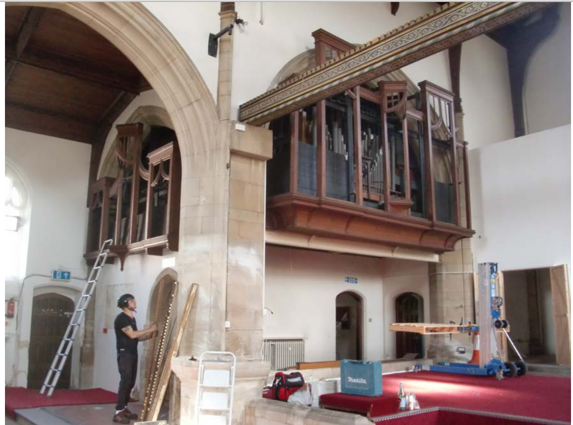
Démontage de la tuyauterie du Great
