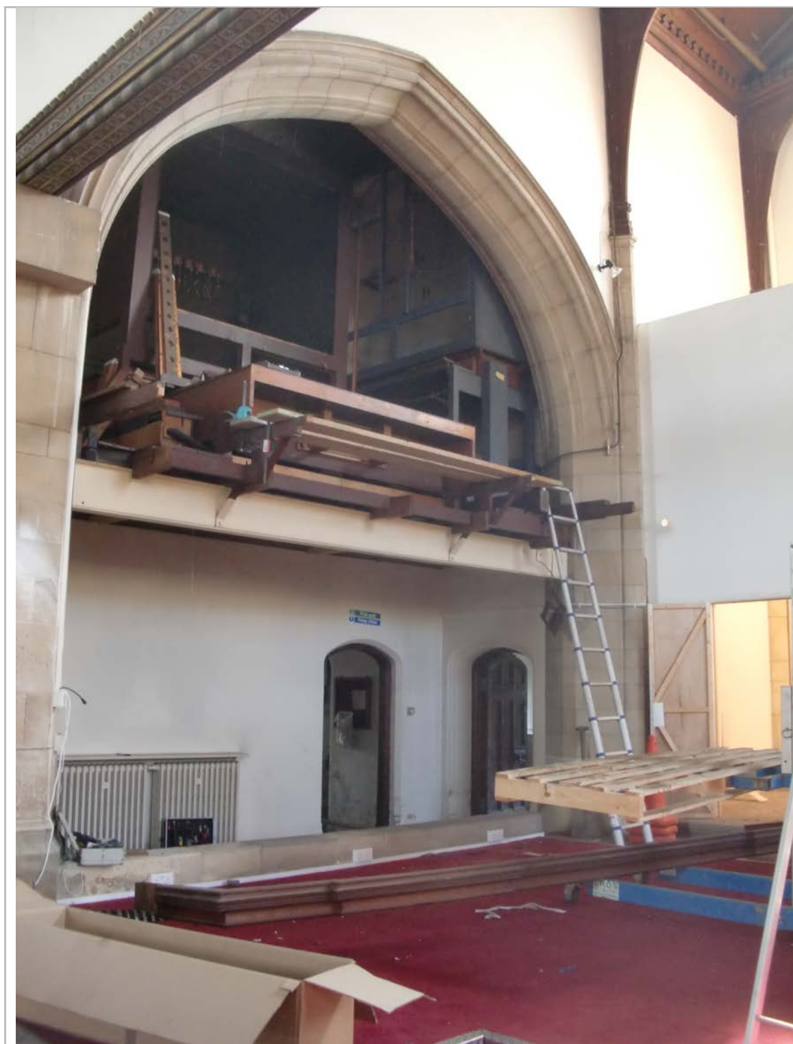
Tuyaux des trois claviers démontés ainsi que toute la façade principale
