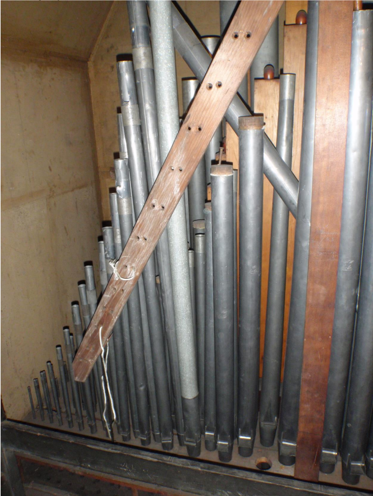
Démontage tuyauterie Swell 2 Basses de Gambe bouchées
