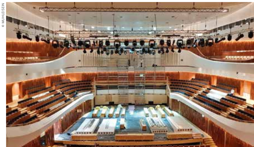
Installation de la façade.
